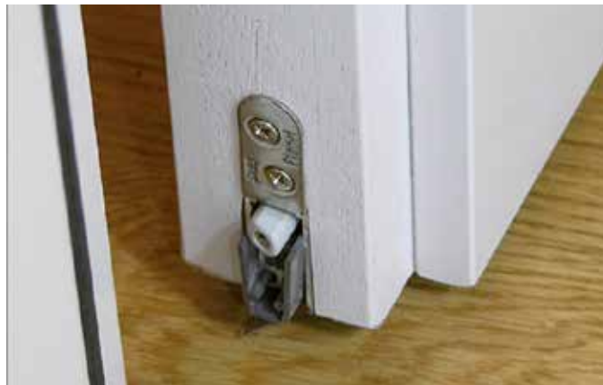
Beispiel Bodendichtung Tür
